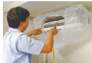
3. 高圧洗浄 高圧洗浄機で汚れを除去
